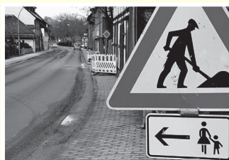
Viele Baustellen sind nicht gemäß den geltenden Vorschriften abgesichert.
